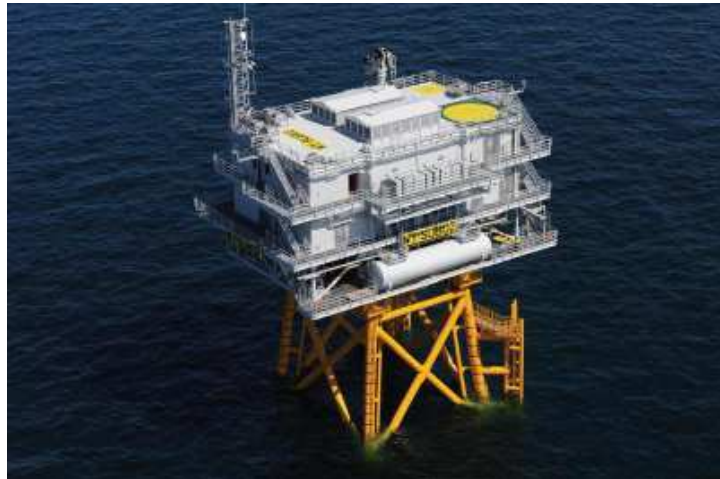
Figure 5 : Poste électrique en mer du parc éolien de Walney, fourni à titre d'illustration (source : étude d'impact)
